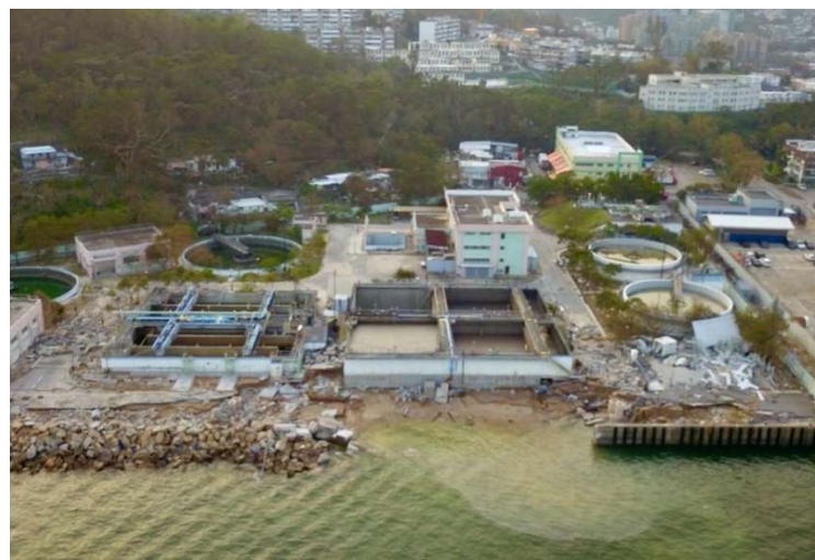
▲ 西貢污水處理廠海堤損毀
