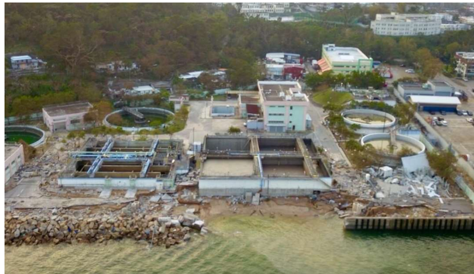
◀ 西貢污水處理廠於山竹吹襲後的情況
