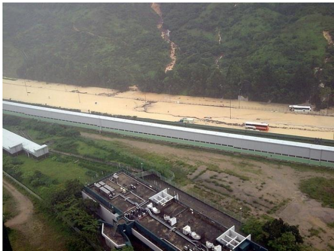
大嶼山快速公路水浸 (原相: WiNG)
