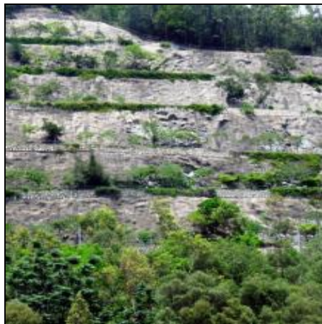
以扶壁及岩釘 穩定削石坡
