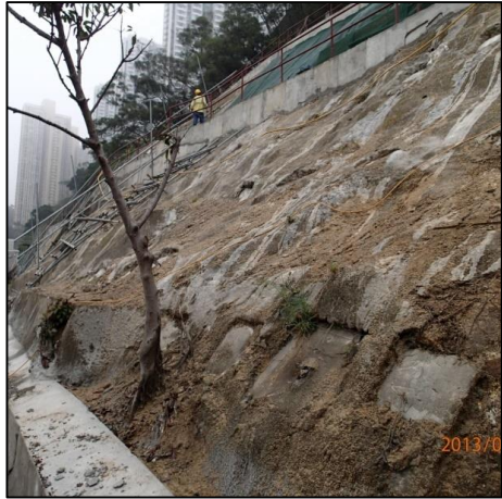
利用泥釘鞏固斜坡
