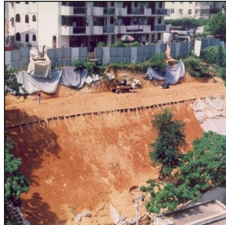
重新壓實鬆散的填土
