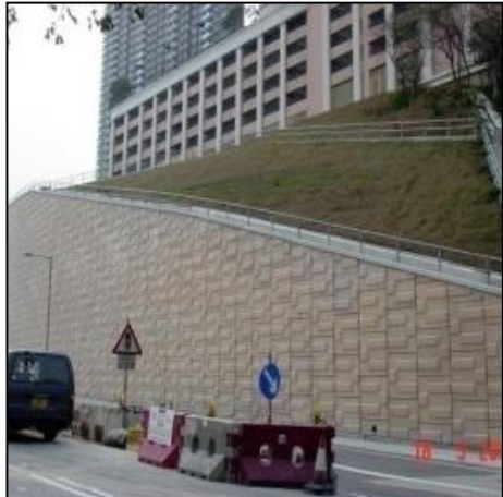
利用泥釘及混凝土 附加表牆鞏固擋土牆
