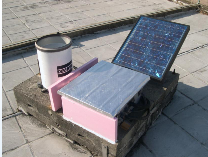
自動雨量計、控制箱及太陽能板
