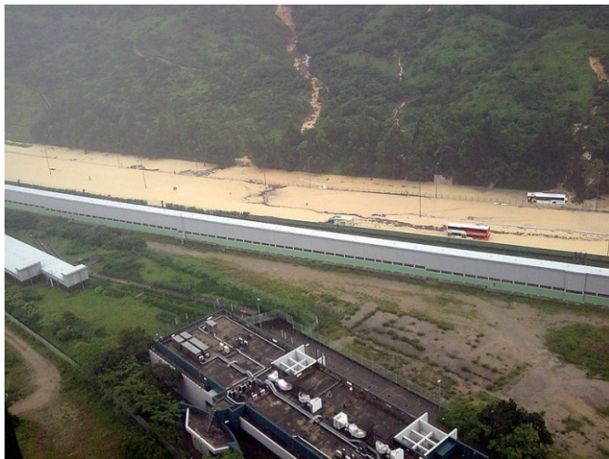
大嶼山快速公路水浸 (原相: WiNG)
