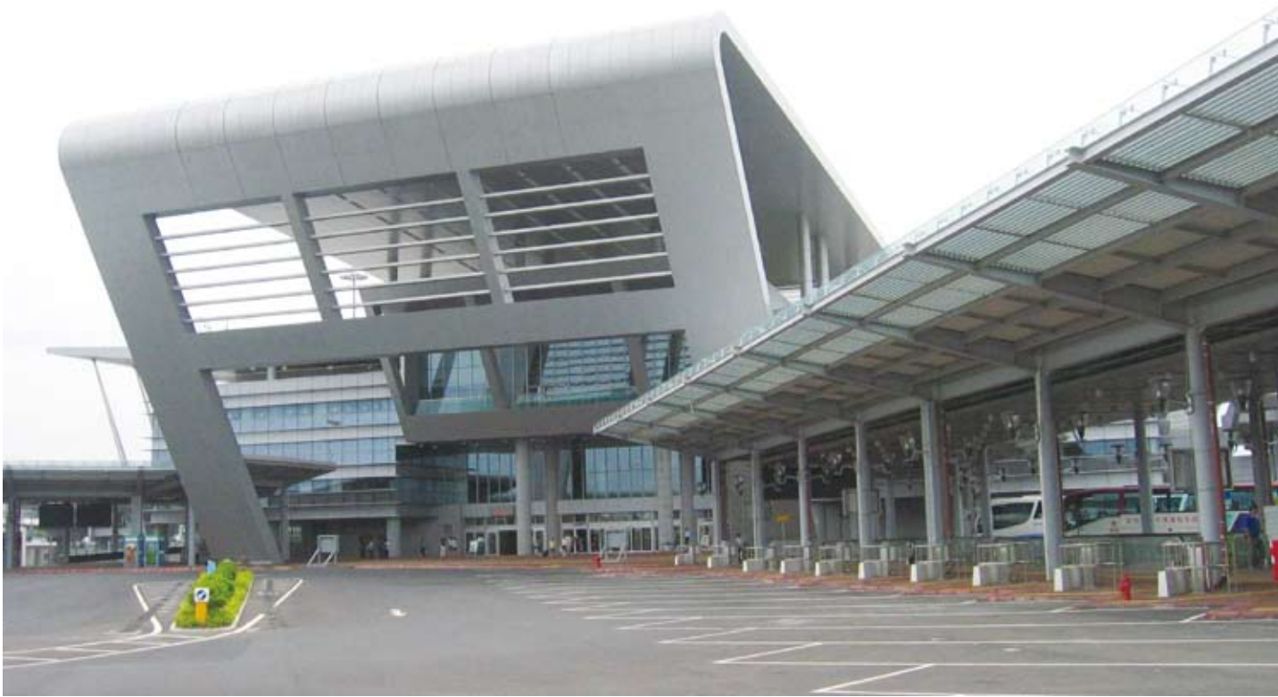
▲ 深港西部通道（深西）及后海灣幹線所配備的交通控制與監測系統，使往返口岸變得更安全和快捷。
