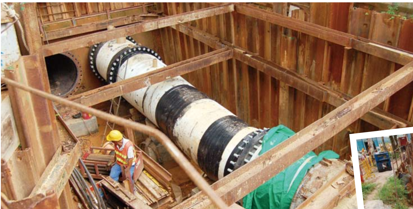
▲ 為減低老化水管的爆漏情況，水務署於2000年開始分階段更換及修復老化的水管。
