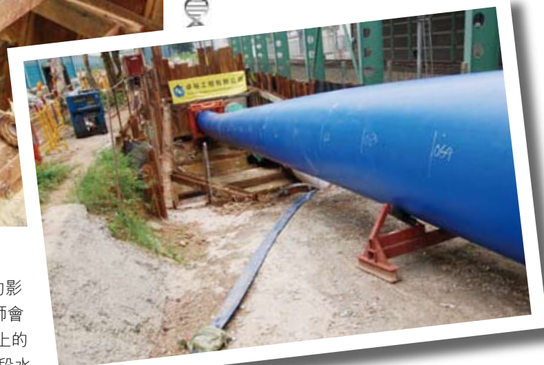
▲ 工程人員正以機器把新喉管從進口井，套進現有的鋼管裏，再慢慢拖至接收井。
